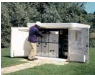
Equipamento de manobra de MT e BT de um MINIBLOK
