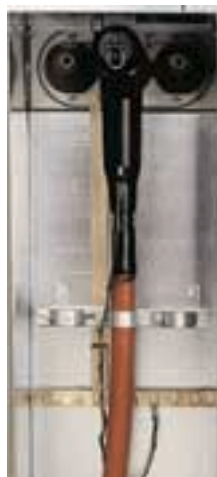
Detail connexion Borne en T EUROMOLD (K-400TB) à visser
