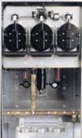
Detail connexion Borne équerre EUROMOLD (K-158LR) embrochable
