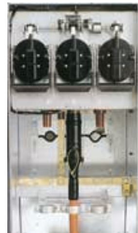
Detail connexion Borne droite EUROMOLD (K-152SR) embrochable
